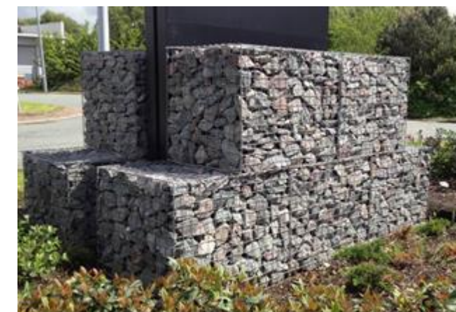
Figure 52 : Exemple de muret en gabion
